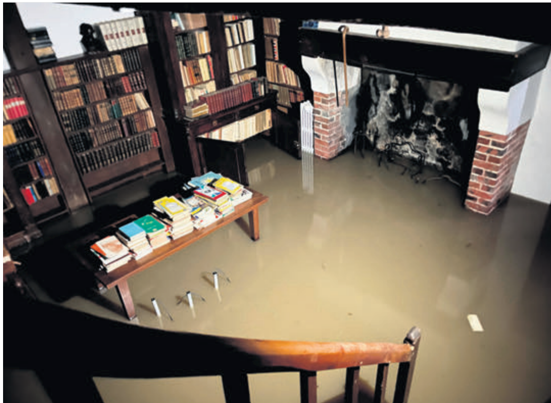
Pus de 1 mètre d'eau a endommagé de nombreuses salles de la bâtisse. MAISON TRIOLET-ARAGON
